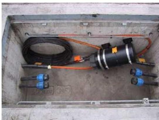
Figure 13 : Exemple de chambre avec protection d'épissure
